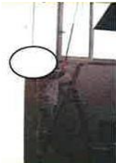
Foto 3- attività di pulizia finestre: altezza massima prevista 3° gradino, una mano di presa sulla scala, seconda mano con uso di manico telescopico allungabile.
