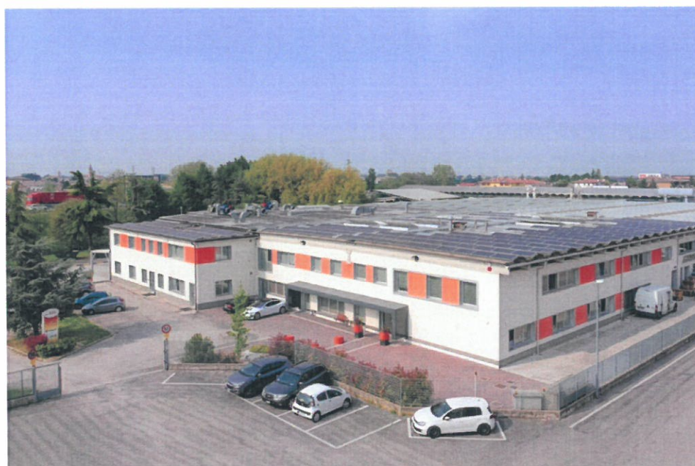
Figura 4 – Impianti fotovoltaici sul tetto del Centro cottura di Torri di Quartesolo (VI)
