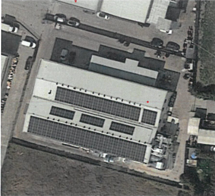
Figura 5 – Impianto fotovoltaico sul Centro cottura di Legnaro (da Google maps)
